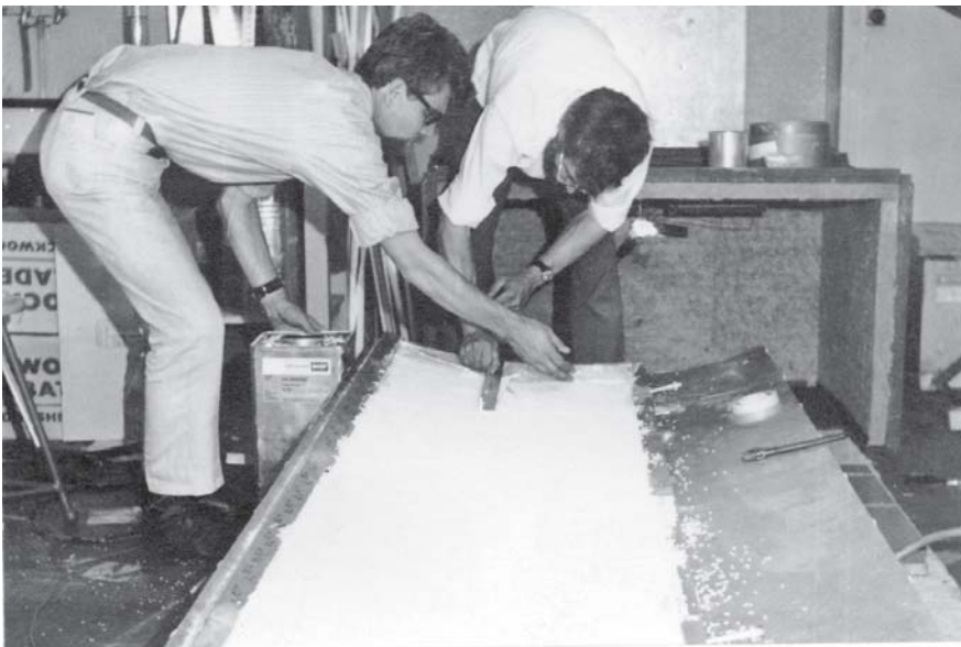
Nylongranulat lægges på skallen for at opnå jævnt limtryk over hele overfladen.
