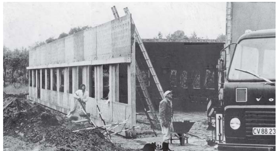
Lundtofte-værkstedet under opførelse - i billedet den vestlige del.
