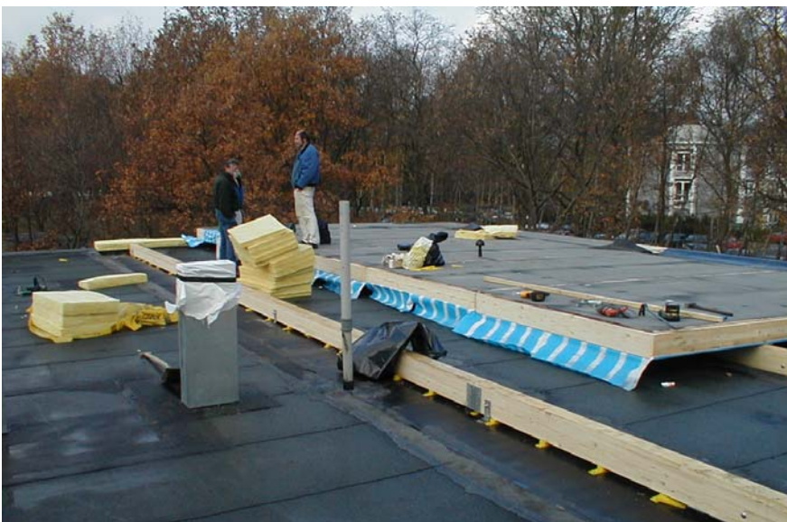
Elementmontage af det nye tag på værkstedet i Lundtofte (Nov. 2000)
