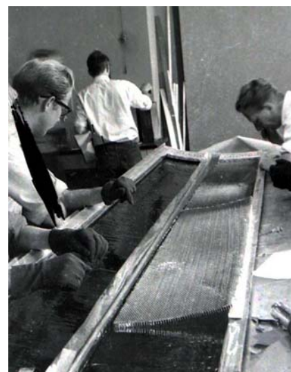
Oplægning af skal til limning i vingeformen. Man ser aluminiumshoneycomb som anvendes til fyldstof.
